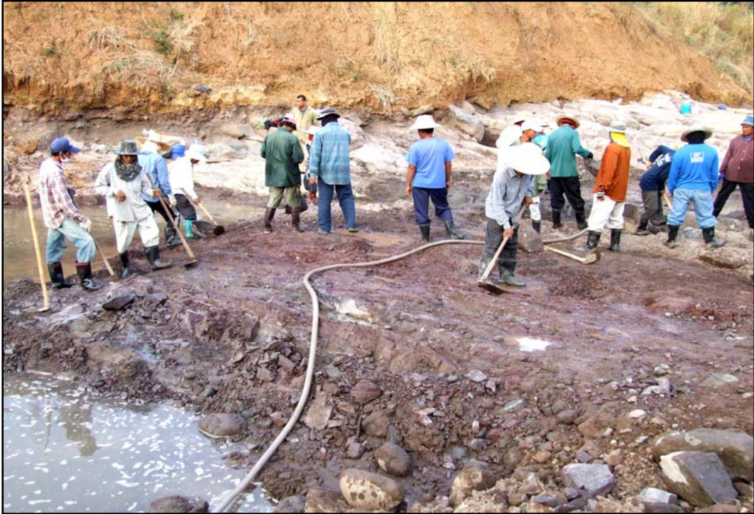
งานขุดลอกลำน้ำเดิมด้วยแรงคนงาน
