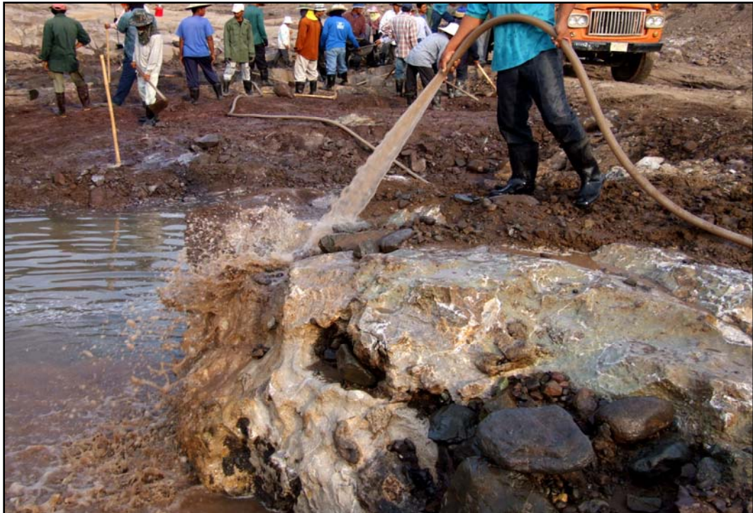
งานขุดลอกลำน้ำเดิมด้วยแรงคนงาน
