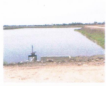
ภาพถ่ายงานแล้วเสร็จ
