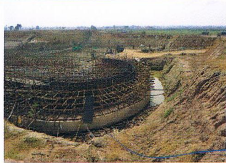
งานอาคารระบายน้ำล้น
