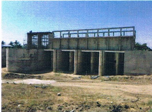
ภาพถ่ายงานก่อสร้างอาคาร
