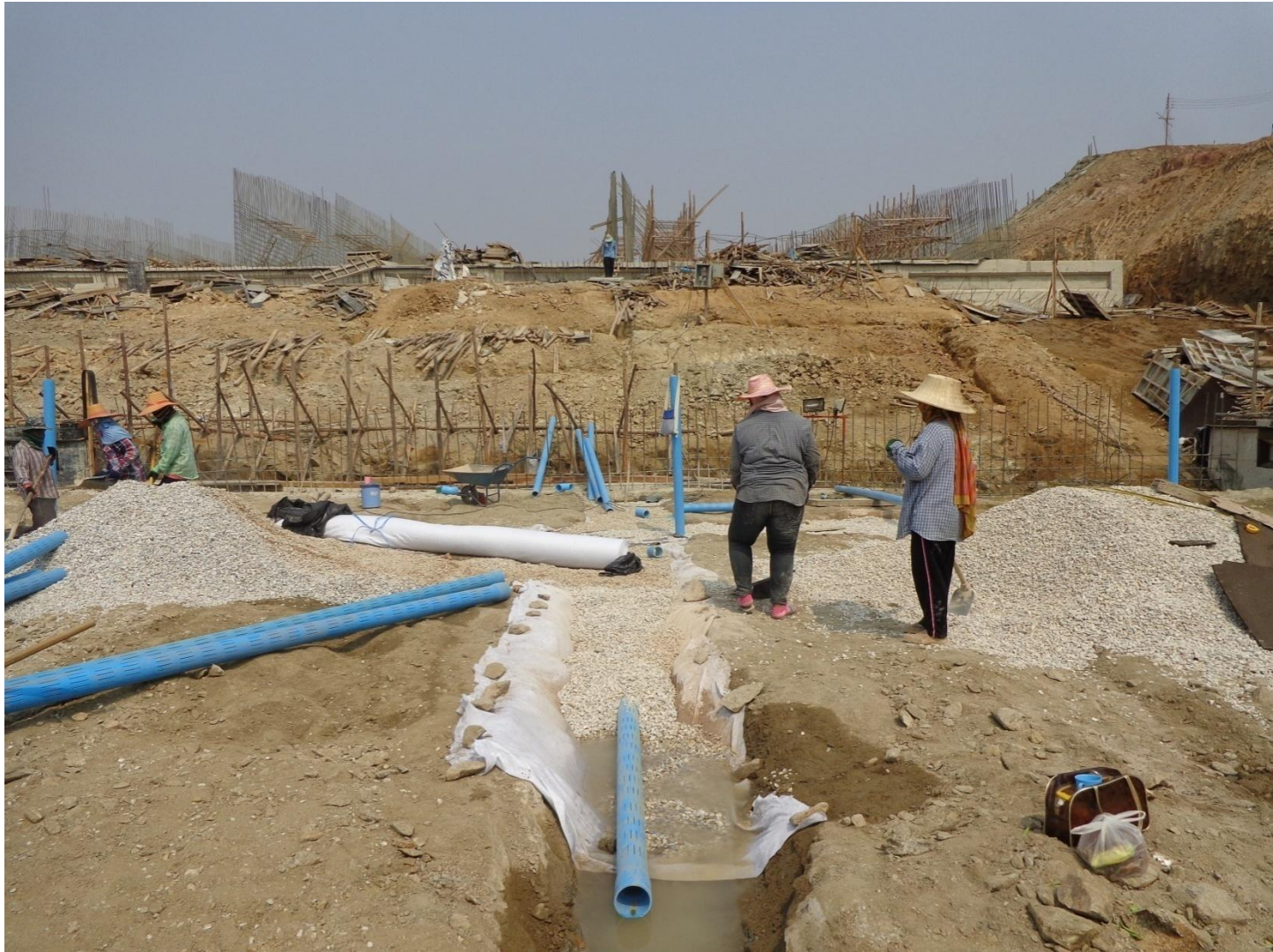
งาน BOTTOM DRAIN
