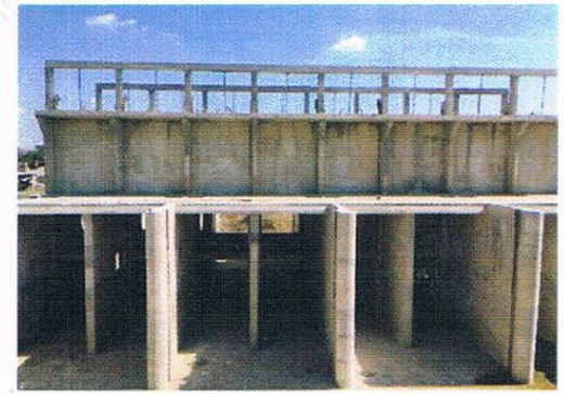
ภาพถ่ายงานก่อสร้างอาคาร
