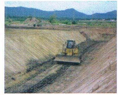
งานบดอัดร่องแกน
