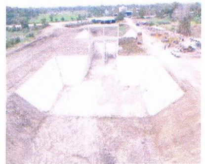
งานอาคารปตร. ลาดน้ำเตียน
